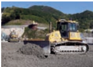
自動ブルドーザの稼動状況
