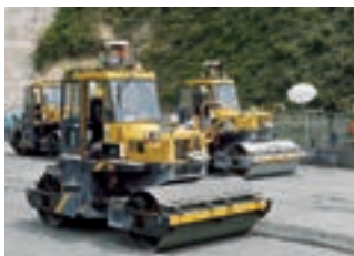
自動震動ローラの稼動状況
