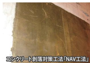
コンクリート剥落対策工法「NAV工法」
