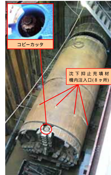
写真 - 1.7 シールドマシン
