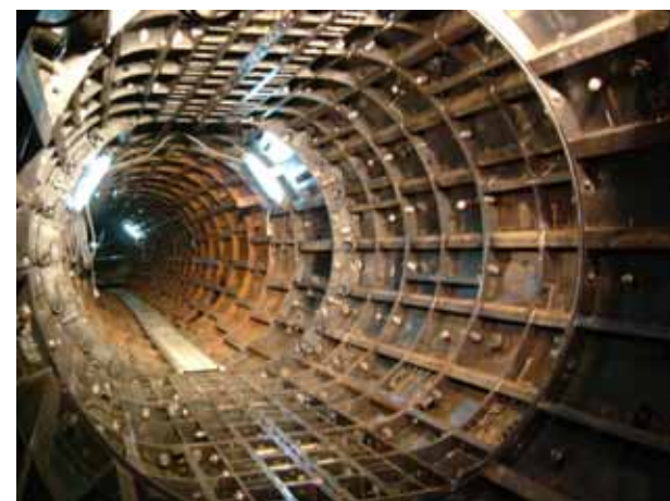
写真 - 1.6 拡幅施工後断面
