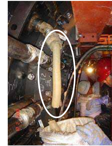
写真 - 1.8 充填材回収状況
