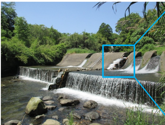
蛇カゴを利用した組立式魚道
