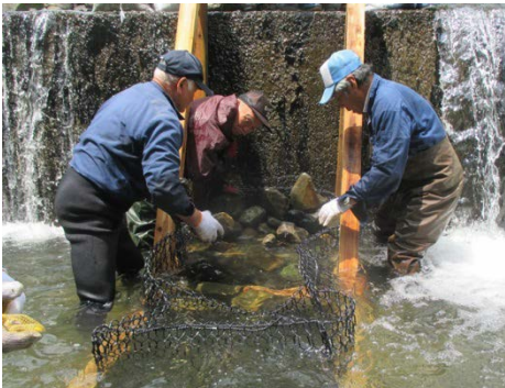
組立式蛇カゴ魚道を設置する様子
