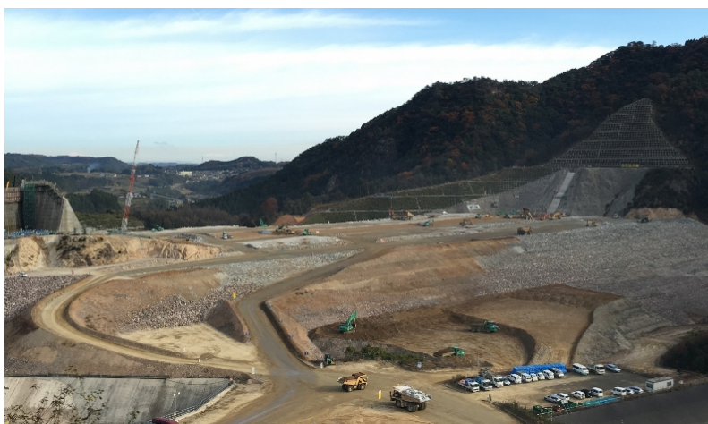
大分川ダム堤体コア盛立施工部での様子(全景)
