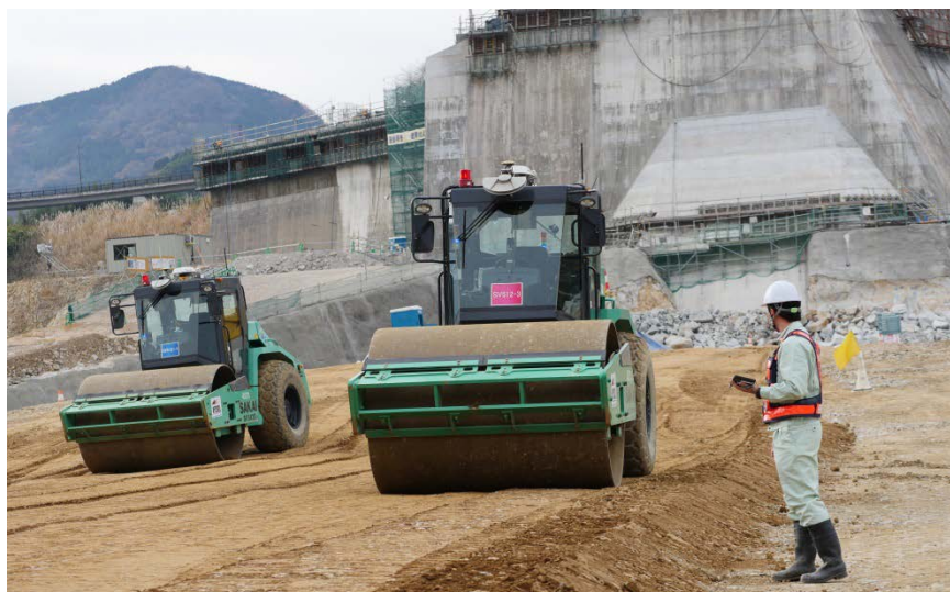
コア盛立部での2台の自動振動ローラでの転圧作業
