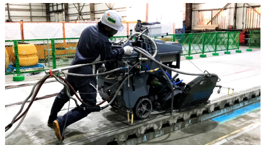
Photo 2 試験体の斜め切断状況
