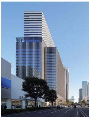
Yokohama Connect Square (Kanagawa Prefecture)
