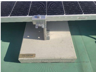
Yokohama Elementary School (Kanagawa Prefecture)
