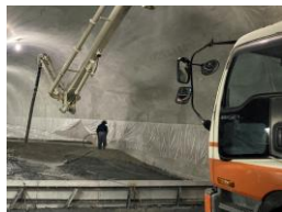
Pouring of ECM concrete
