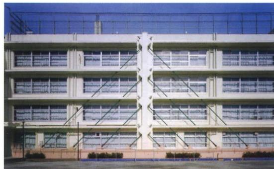
斜張橋の原理で耐震補強「パラレル構法」適用物件
