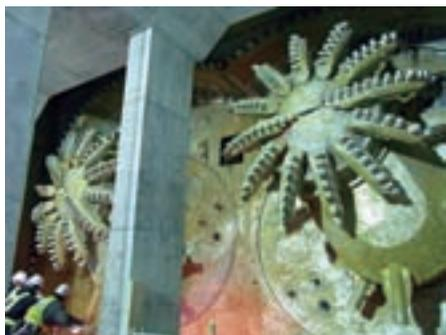
●**東急東横線地下化工事のシールドマシンが到達**
