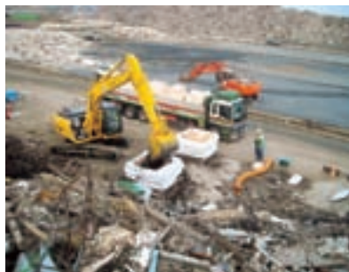
廃棄物の処理状況
