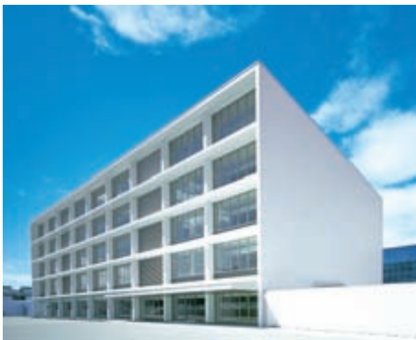
北側外観全景
