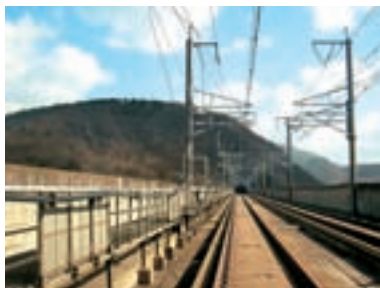
復旧完了した電架柱
