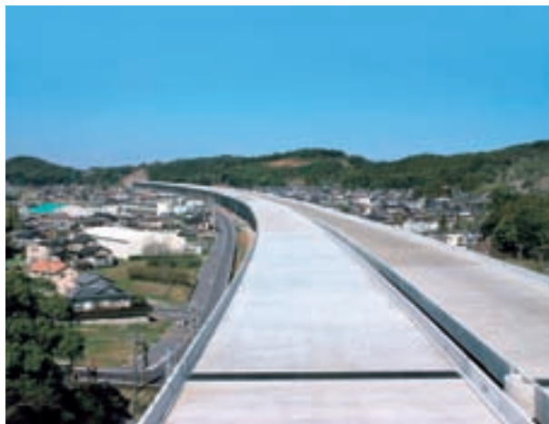
■ 第二東名高速道路 浜北高架橋（PC上部工）西下り線
