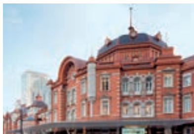
復原後の南ドーム
