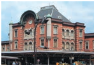
工事着工前の南ドーム
