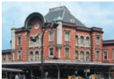
工事着工前の南ドーム
