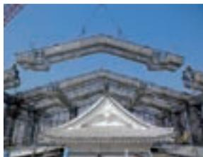
昭和の大修理と同様に素屋根工事に着手。昭和の素屋根が丸太造りだったのに対し、今回は三次元データで図面を作成するなど最新技術を駆使し、鉄骨で構築しました。
