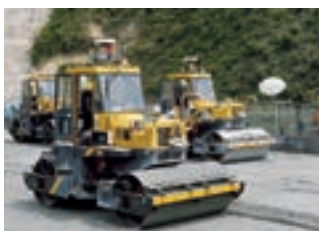
自動震動ローラの稼動状況
