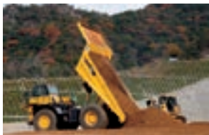
自動ダンプトラックの稼働状況
