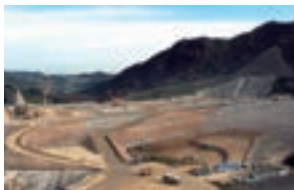
大分川ダム堤体盛立工事全景
