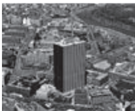
完成当時の霞が関ビル
