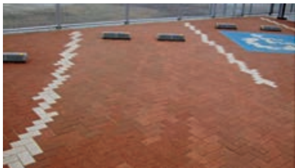
舗装ブロック、境界ブロック、フェンス基礎ブロックに採用。写真は舗装ブロック
