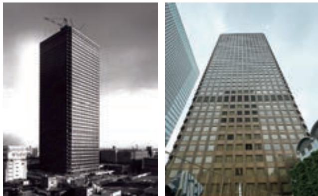
左：1969年 施工当時の世界貿易センタービルディング 右：解体する世界貿易センタービルディング
