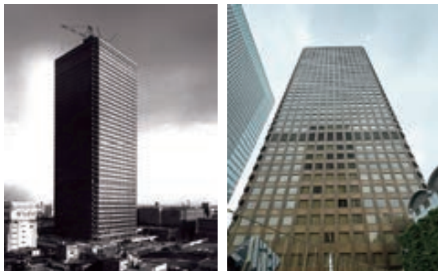
左：1969年 施工当時の世界貿易センタービルディング 右：解体する世界貿易センタービルディング
