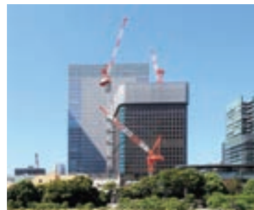
解体状況（2022年9月）
