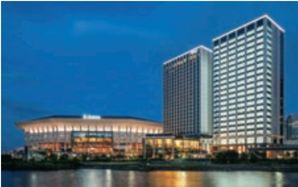
■ ミュージックテラス (Kアリーナ横浜・ヒルトン横浜・Kタワー横浜) (横浜市)
