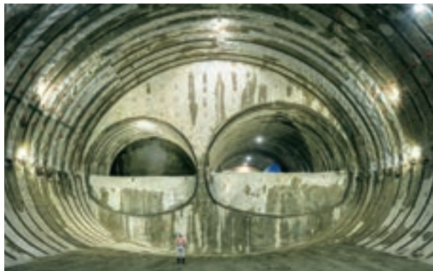
世界最大級の掘削断面積485㎡を達成
