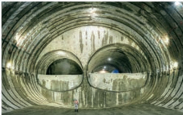
世界最大級の掘削断面積485㎡を達成
