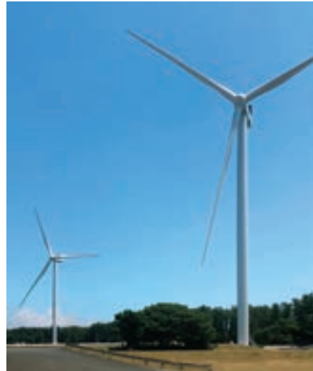
■ あつみ風力発電所 (愛知県)
