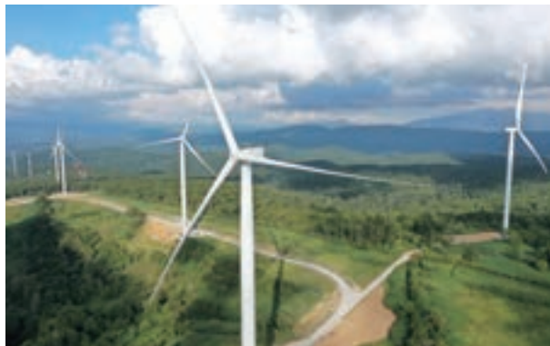
■留寿都風力発電所 (北海道)
