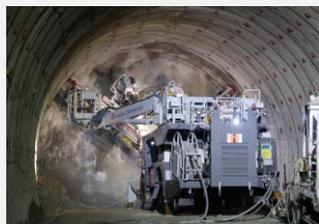
「A<sup>4</sup>CSEL for Tunnel」自動化されたロックボルト施工
