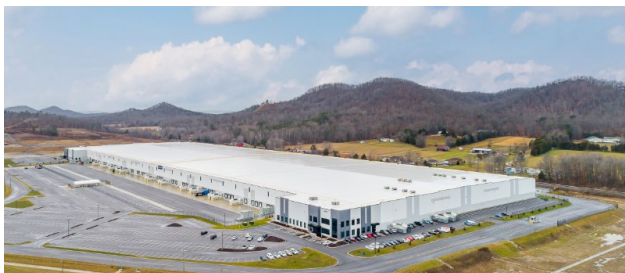
Bourbon Building 3（米国 ケンタッキー州）
