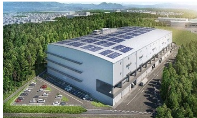
（仮称）鹿島富谷物流センター（宮城県）
