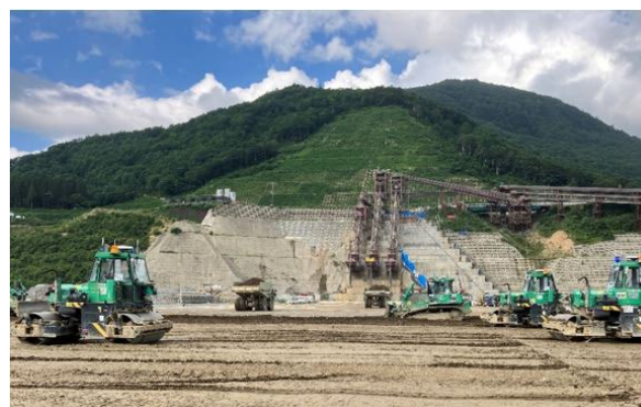
自動化施工技術「A 4 CSEL（クワッドアクセル）」による施工を進める成瀬ダム堤体打設工事（秋田県）
