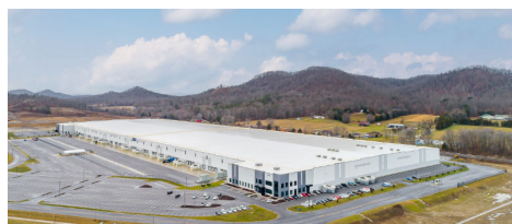
Bourbon Building 3（米国 ケンタッキー州）
