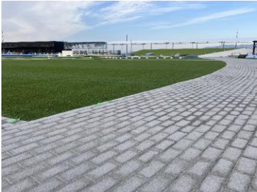
会場の舗装（約3,300㎡）に CO 2 吸収コンクリートを活用
