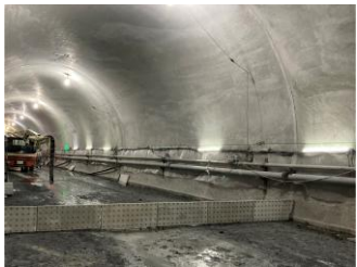
CO 2 -SUICOM 埋設型枠の設置
