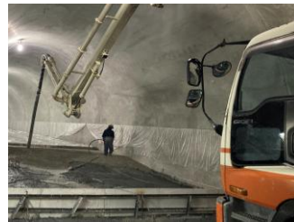
ECMコンクリートの打設
