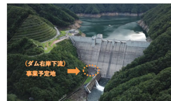
湯西川ダム新水力発電所設置・運営事業(栃木県)
