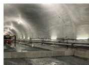
CO 2 -SUICOM 埋設型枠の設置
