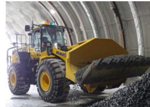
自動化施工実証試験(トンネル)
