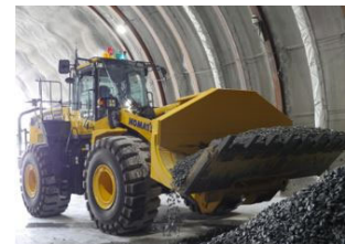
自動化施工実証試験(トンネル)
