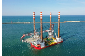
秋田港・能代港洋上風力発電施設建設工事
