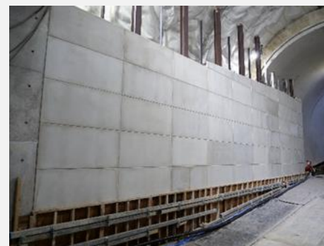
日下川新規放水路トンネル（高知県） 「埋設型枠」設置状況
