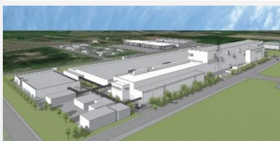
TDK北上工場新棟建設工事（岩手県）
