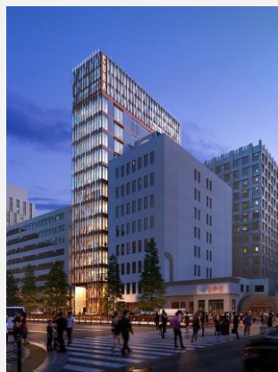
CURA 銀座 [事務所・商業施設] (建設中)
