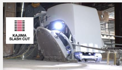
世界貿易センタービルディング（東京都港区） の解体工事に適用中の「鹿島スラッシュカット工法」
