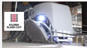
世界貿易センタービルディング（東京都港区） の解体工事に適用中の「鹿島スラッシュカット工法」
