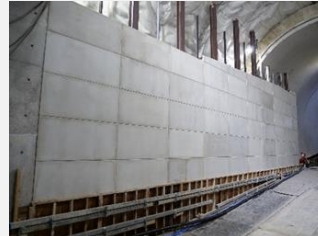
日下川新規放水路トンネル（高知県） 「埋設型枠」設置状況
