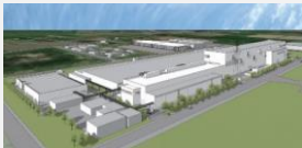
TDK北上工場新棟建設工事（岩手県）
