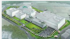
東和薬品株式会社山形工場 第三期建設工事（建築工事）
