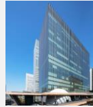
横濱ゲートタワー 2022年3月開業
