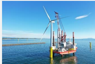
秋田港・能代港洋上風力発電 施設建設工事は全33基の風車 据付が完了
