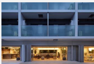
環境配慮型コンクリートが適用された社有施設 ドミー南長崎アネックス（東京都豊島区）
