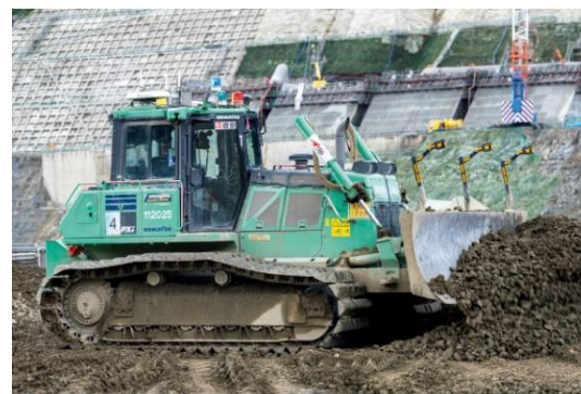
成瀬ダム堤体打設工事（秋田県）
