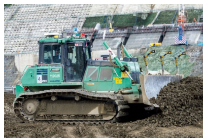
成瀬ダム堤体打設工事（秋田県）
