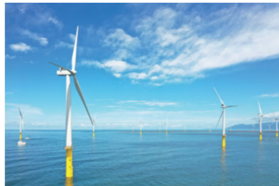
秋田港・能代港洋上風力発電施設建設（秋田県）
