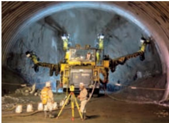
4ブームフルオートコンピュータジャンボによる削孔の様子
