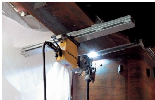
鉄骨溶接ロボットによる梁上向き溶接
