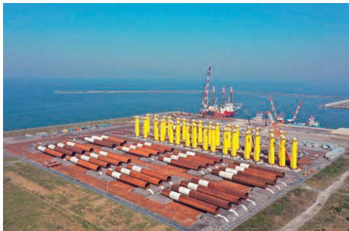
モノパイル、トランジッションピース保管の様子
