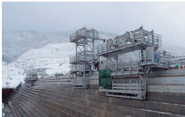
成瀬ダムの置き型枠自動スライドシステム
