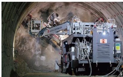
2ブームロックボルト施工機
