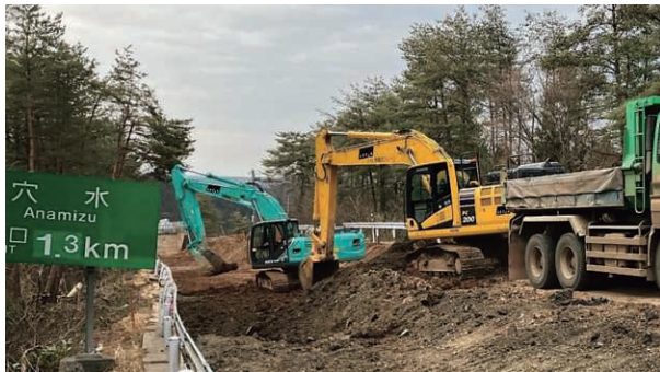
のと里山海道の復旧工事
