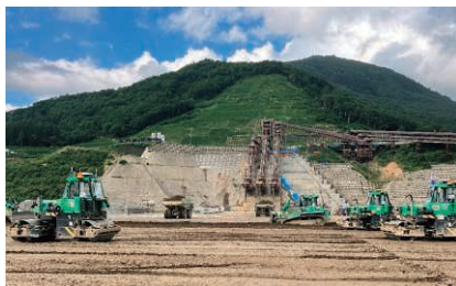
成瀬ダムでは3機種14台の自動化重機が稼動
