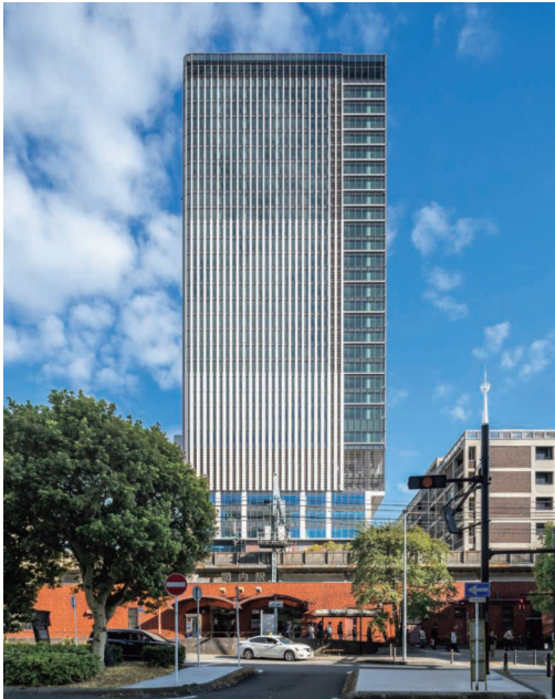
■ BASEGATE横浜関内 タワー (神奈川県)
