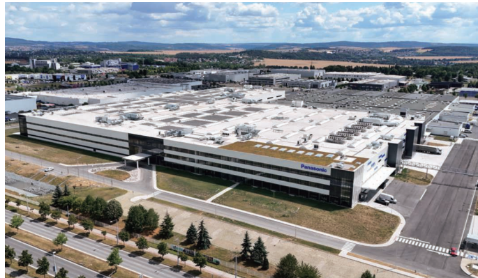
■ パナソニックHVACチェコ新P1棟 (チェコ)
