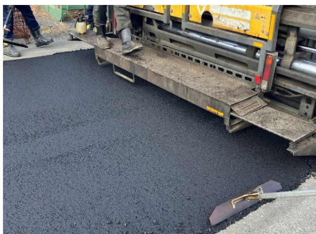
「サーキュラプラス舗装」の施工状況
