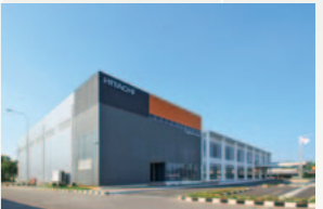
◆日立建機インドネシアチピトン工場(2010-2012)
