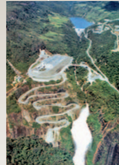
シグラグラ地下発電所(1978-1983)
