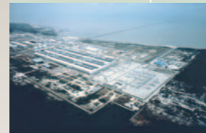
スメルター電解工場(1979-1983)
