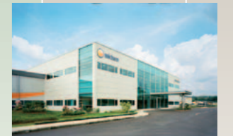
◆ユニ・チャームインドネシア第1工場(2009-2010)
