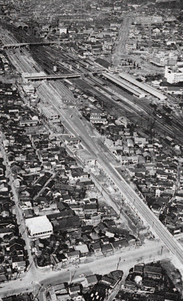
新豊橋駅を中心とする豊橋工区の全景
