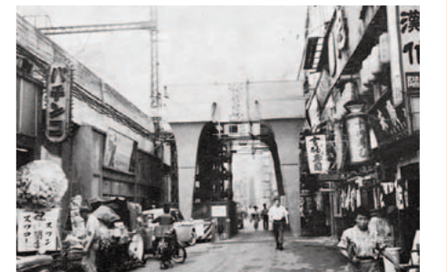
有楽町駅付近高架橋基礎工事。駅と飲食店街の間の狭い路地の間にオレンジ色の橋脚が現れたという
