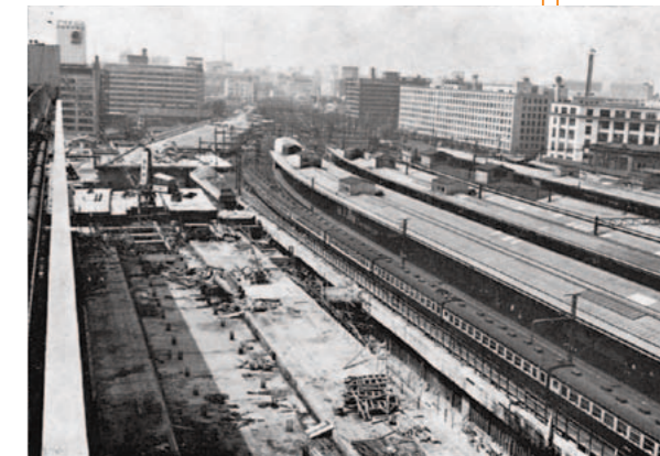
東京駅高架橋工事(大丸デパートから有楽町方面を望む)
