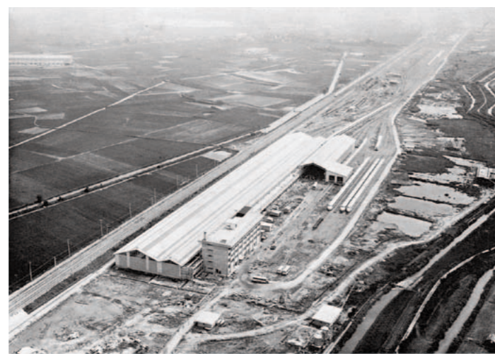
富士川橋梁工事の橋脚が並ぶ姿を表紙にした本誌1962年6月号(左)。西鳥飼工区・大阪電車基地は新幹線の操車、整備点検を行う大操車場(右)
