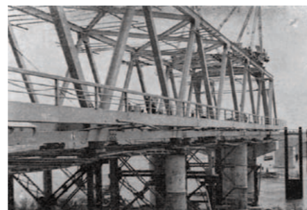
天龍川橋梁。工事期間中に5回の水禍に遭遇したものの、工期中に完成したという
