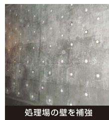
処理場の壁を補強
