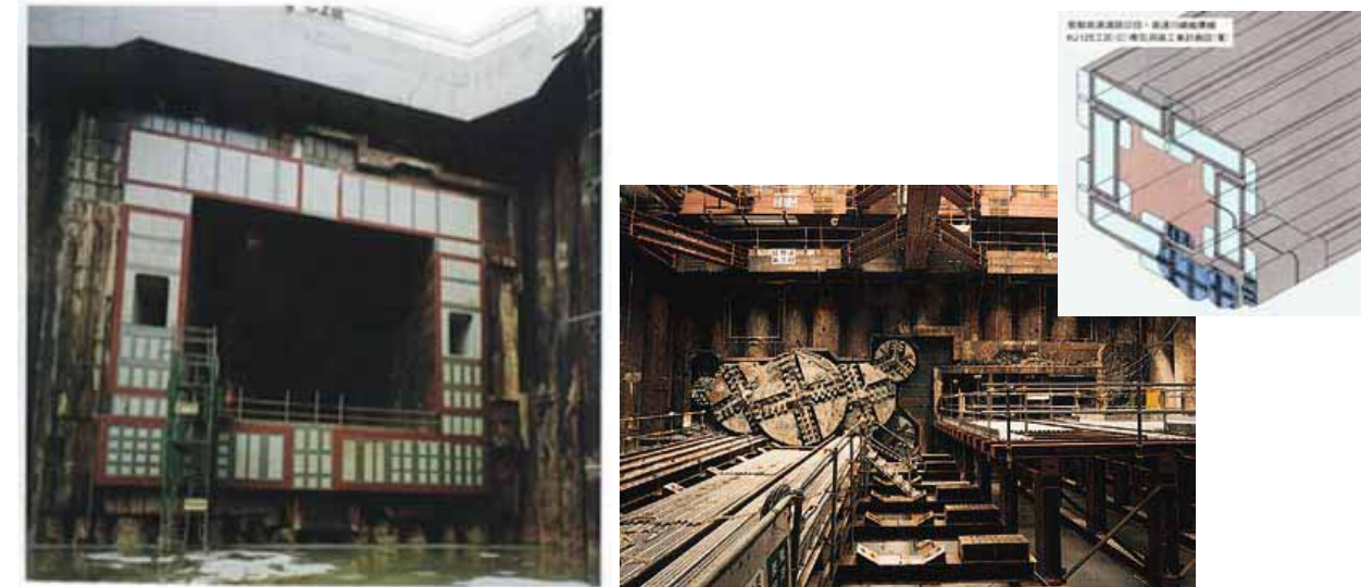
図 - 2 . 6 首都高MMST工法の実証施工事例
