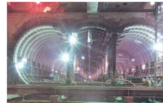
図 - 2 . 7 異型シールドによる実証施工事例
